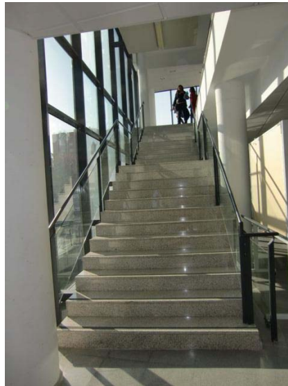
Foto 3. Escalera en la planta baja del aulario
