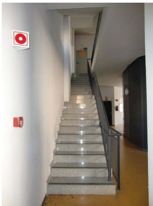
Foto 8. Escalera de la segunda planta (al lado de la sala de informática)
