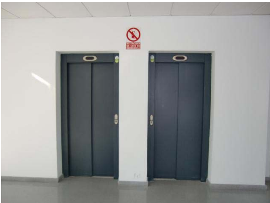
Foto 4. Ascensores en la planta baja del aulario
