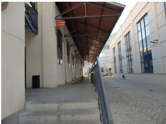
Foto 12. Escalones de la puerta e interior de la Cafetería
